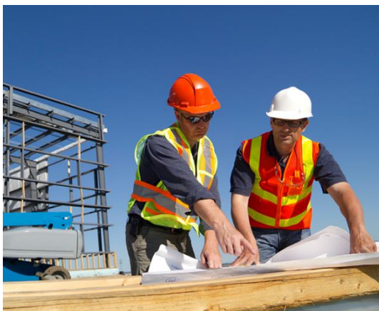
Шеф-монтаж на объекте
