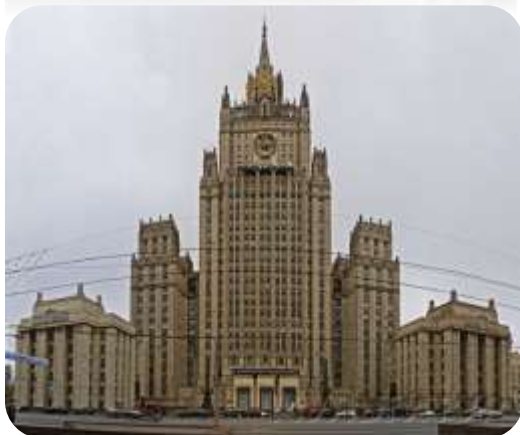
Реконструкция правого крыла здания МИД
